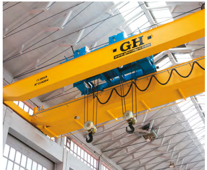
PONTE ROLANTE COM DIFERENCIAL DE DUAS ELEVAÇÕES
