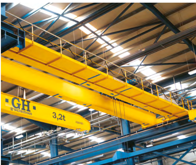
PLATAFORMAS DE MANUTENÇÃO NAS VIGAS
