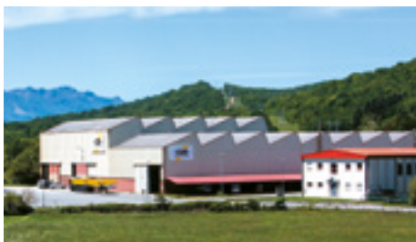
Bakaiku Planta de Calderería / Boilermaking Plant
