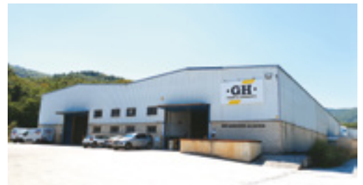
Alsasua Planta de Mecanizado / Machining Plant
